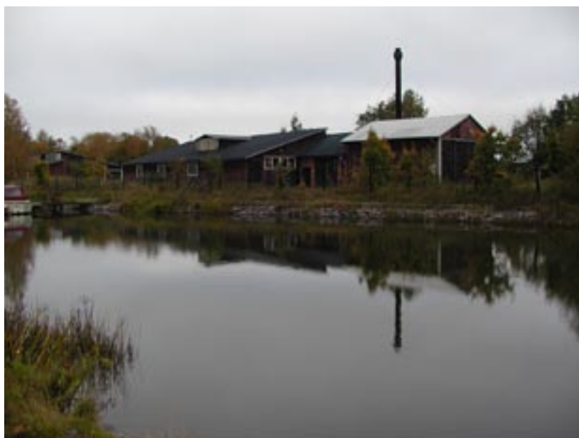
Fig. 7. Kvarvarande delar av sågverket vid Göta kanals strand. Foto från SÖ.
