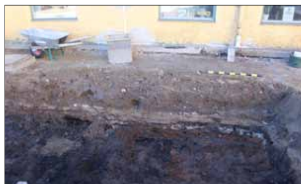
Figur 11. Lager i södra schaktväggen av schakt 16. Foto från norr.
