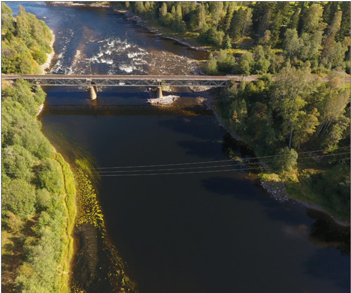
Figur 5. Delområde 1 i Ljungan. Den marinarkeologiska undersökningen genomfördes i anslutning till det södra brofästet. Foto från V.
