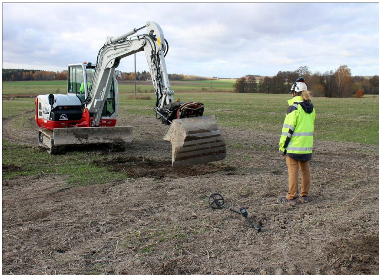
Figur 7. Pågående schaktning inom L2020:6636. Foto från sydöst.
