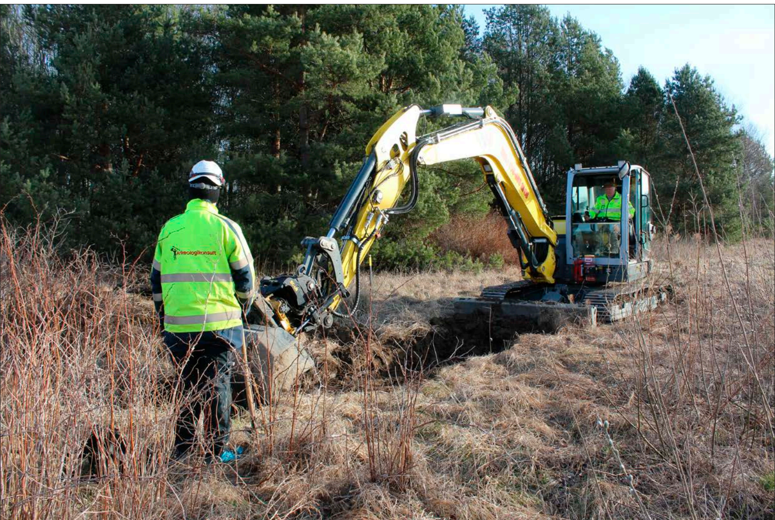
Figur 9. Pågående schaktning inom den sydligaste delen av området. Foto från sydväst.
