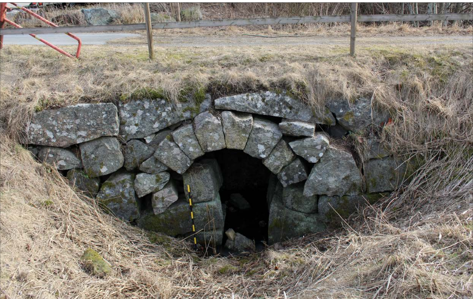
Figur 10. Bro L2017:2418 är en valvbro byggd med tuktad sten. Foto från norr.
