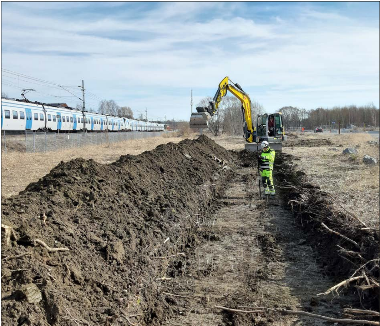
Figur 6. Pågående sökschaktning inom område 2. Foto från väst.
