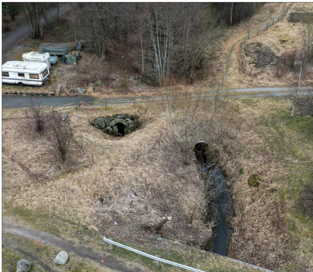
Figur 9. Översikt över bron L2017:2418 och befintlig dragning av bäckfåra. Foto från norr.
