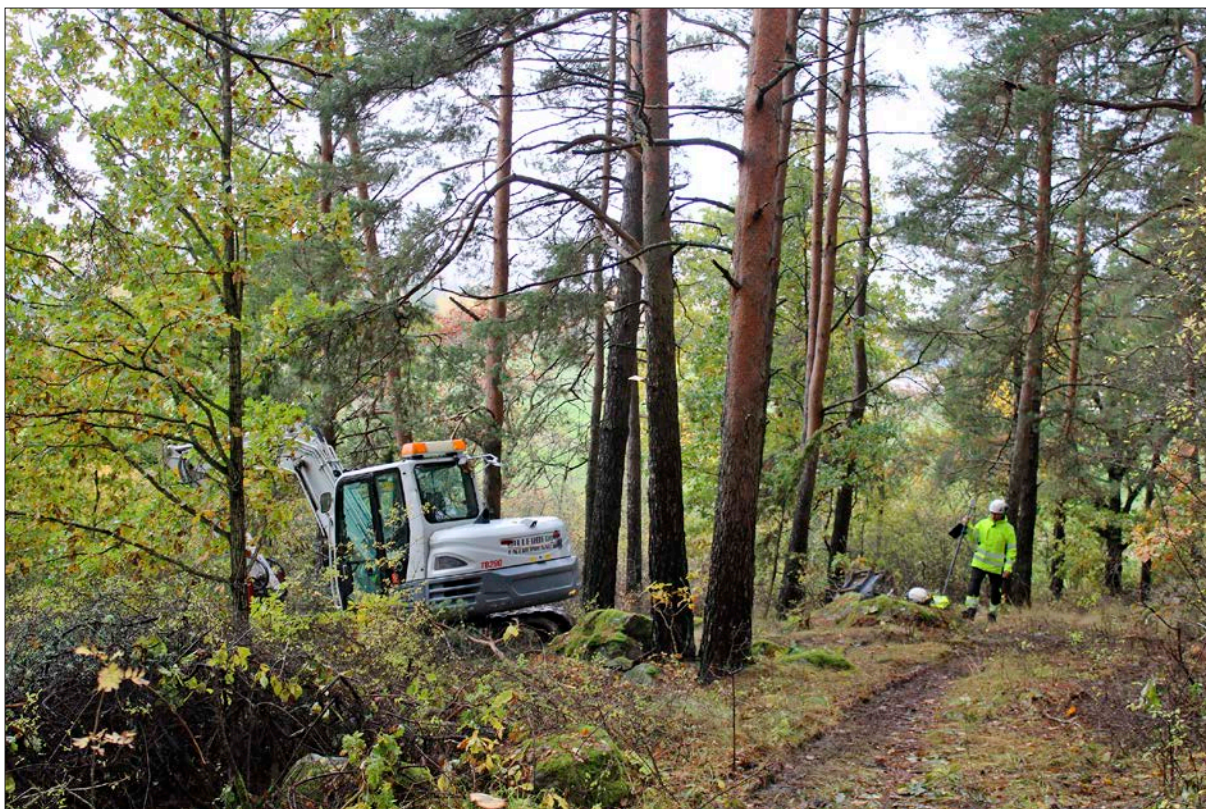
Figur 5. Schaktning i område 4, öster om L2016:3111. Foto från norr.
