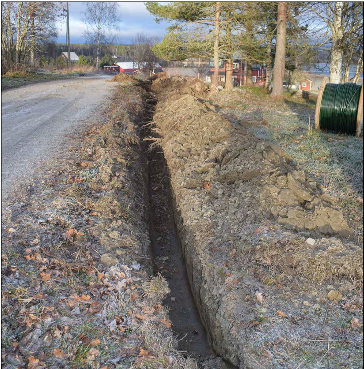
Figur 5. Översiktsbild över schakt 2 inom fastighet Skrämssta 5:4. Foto från söder.
