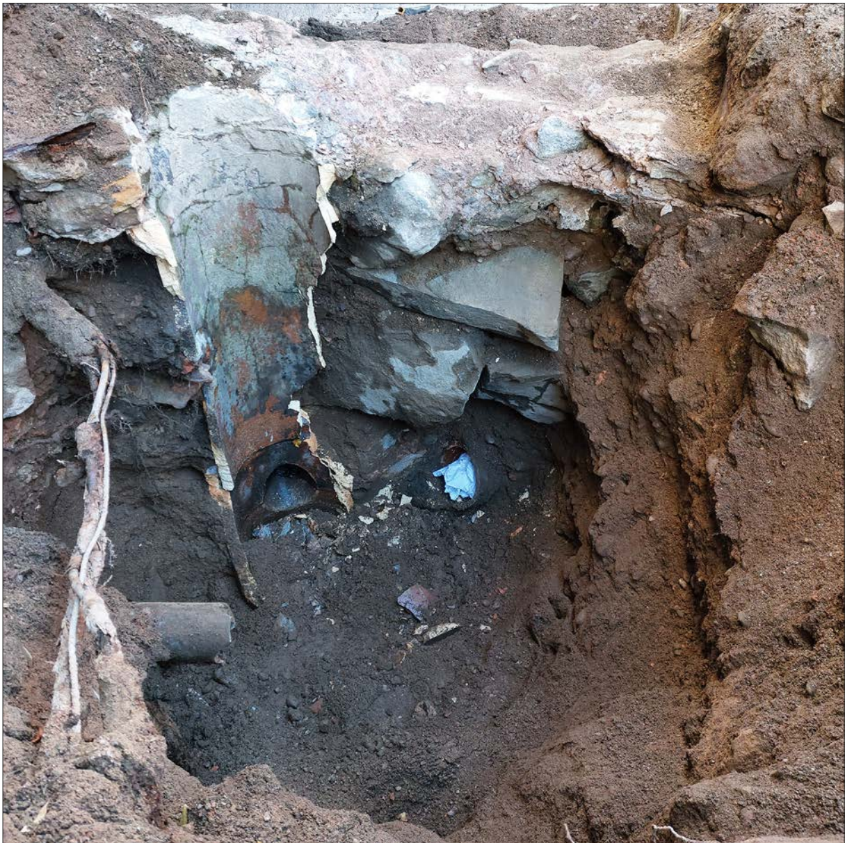
Figur 7. Schakt 1 från söder. Till vänster i bild syns en halverad dagvattenbrunn och bakom denna en stödmur (1) för en trappa.
