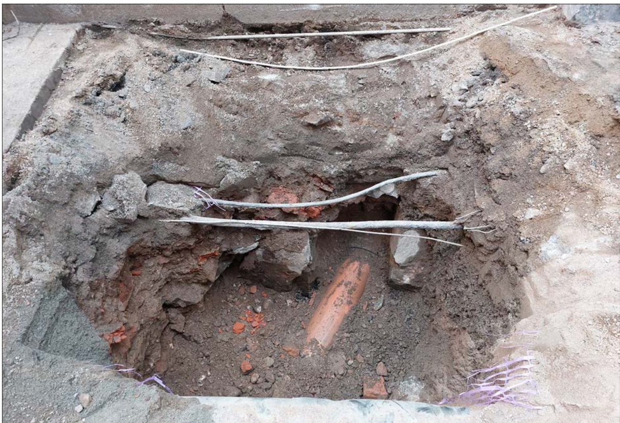
Figur 10. Schakt 4 från öster. I de västra och södra schaktväggarna syns rester av murar som kan knytas till kvarteret Medea. I botten av schaktet syns den befintliga ledning som skulle renoveras. Jämför figur 11.
