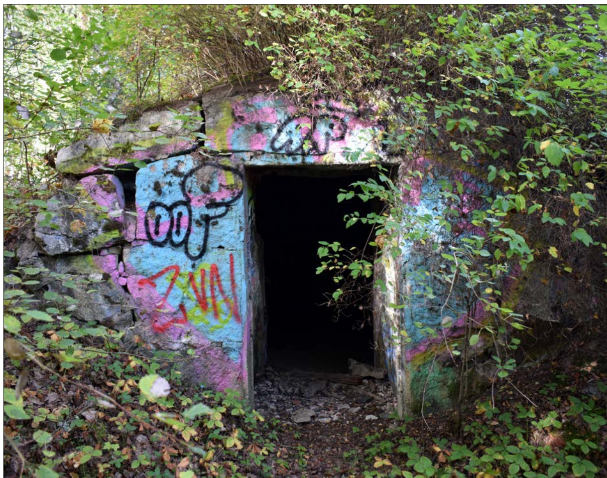
Figur 16. Jordkällaren inom objekt 16. Foto från öster.
