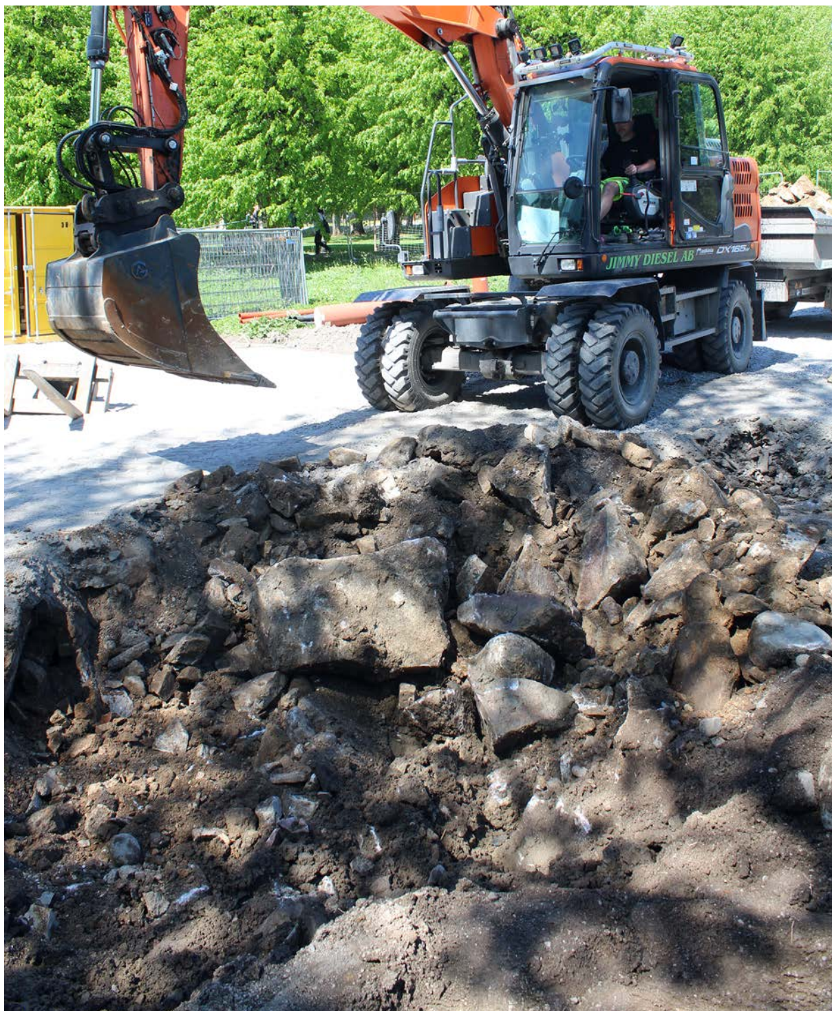
Figur 14. Undersökning med maskin av grundförstärkningen 506. Foto från sydöst.
