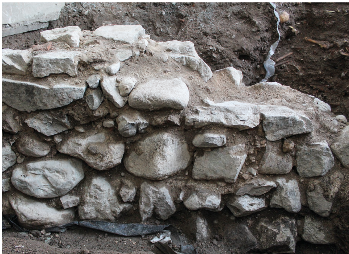
Figur 20. Muren (1316) är uppbyggd av tydliga skikt. Foto från väster. För vidare beskrivning och ritning av muren se sida 40–41.
