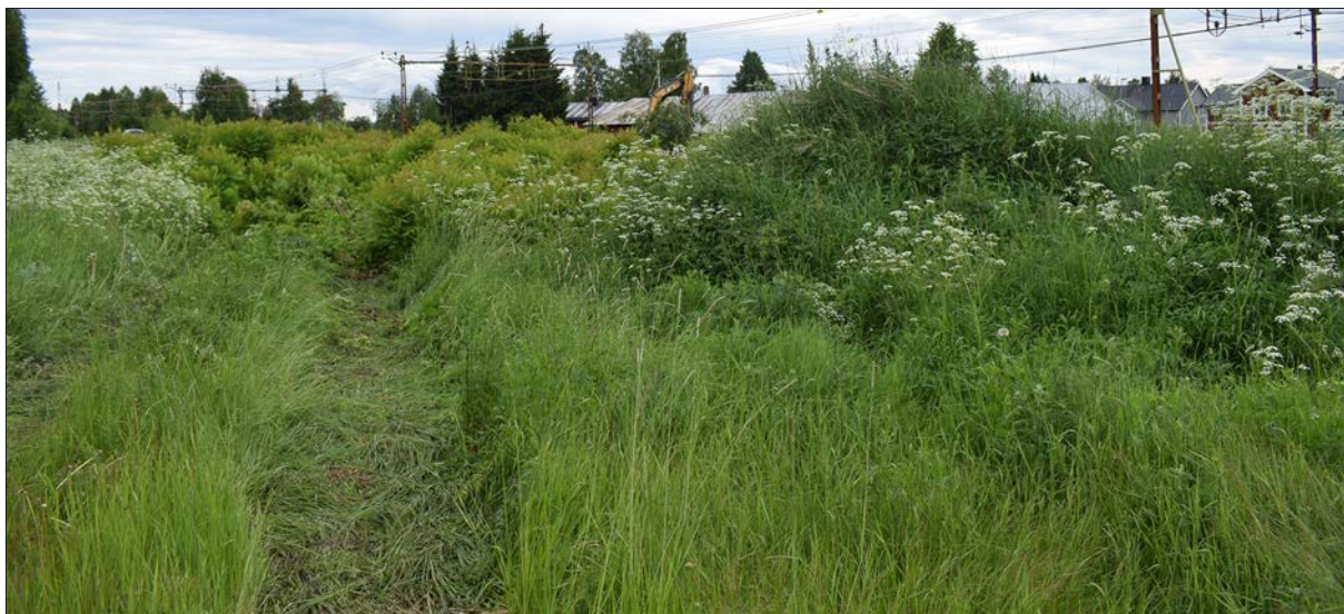
Figur 30. I området fanns högt buskage och påförda jordmassor. Grävmaskinen kan skymtas bakom buskaget. Foto från norr.
