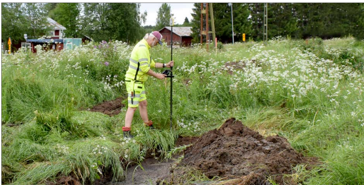
Figur 5. Sökschaktning inom objekt 2. Sverker förbereder för inmätning. Foto från öst.
