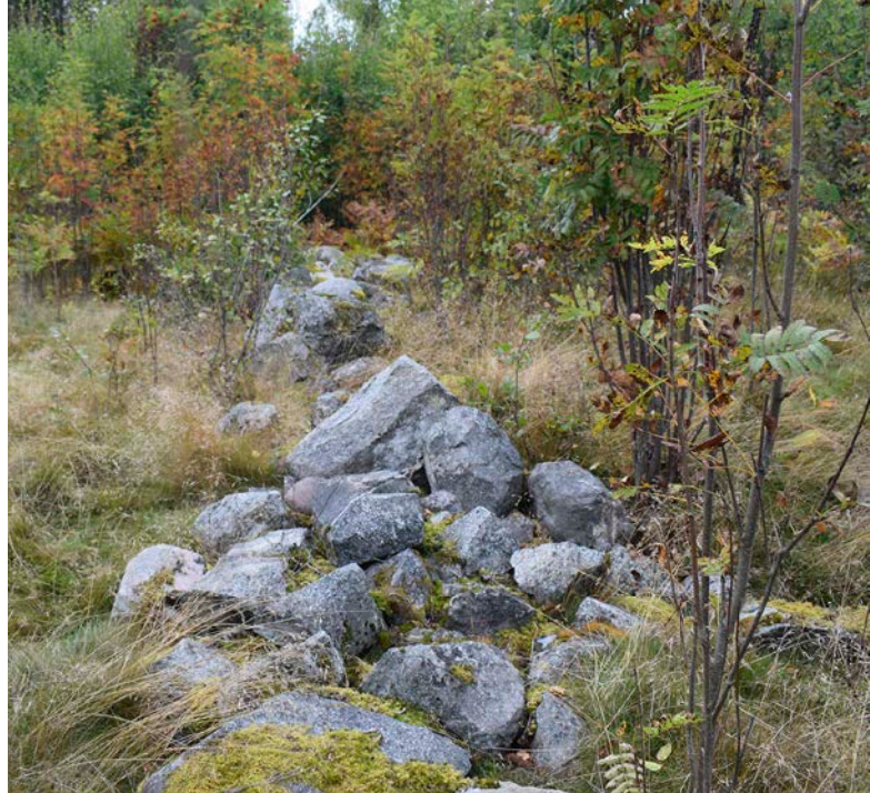
Figur 20. Objekt 7 utgjordes av en stenmur. Foto från syd-öst.
