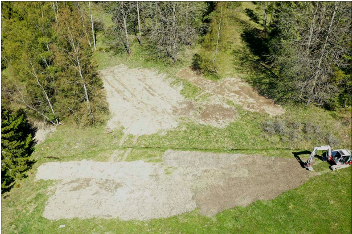
Figur 8. Översiktsfoto på delområde 2 efter avslutad schaktning. Foto från sydost.
