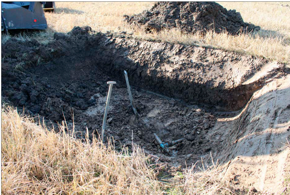
Figur 6. Schaktet i norra delen av fornlämning L2004:9650. Vid cirka 1,1 meters djup framkom u-servisen. Foto från nordväst.
