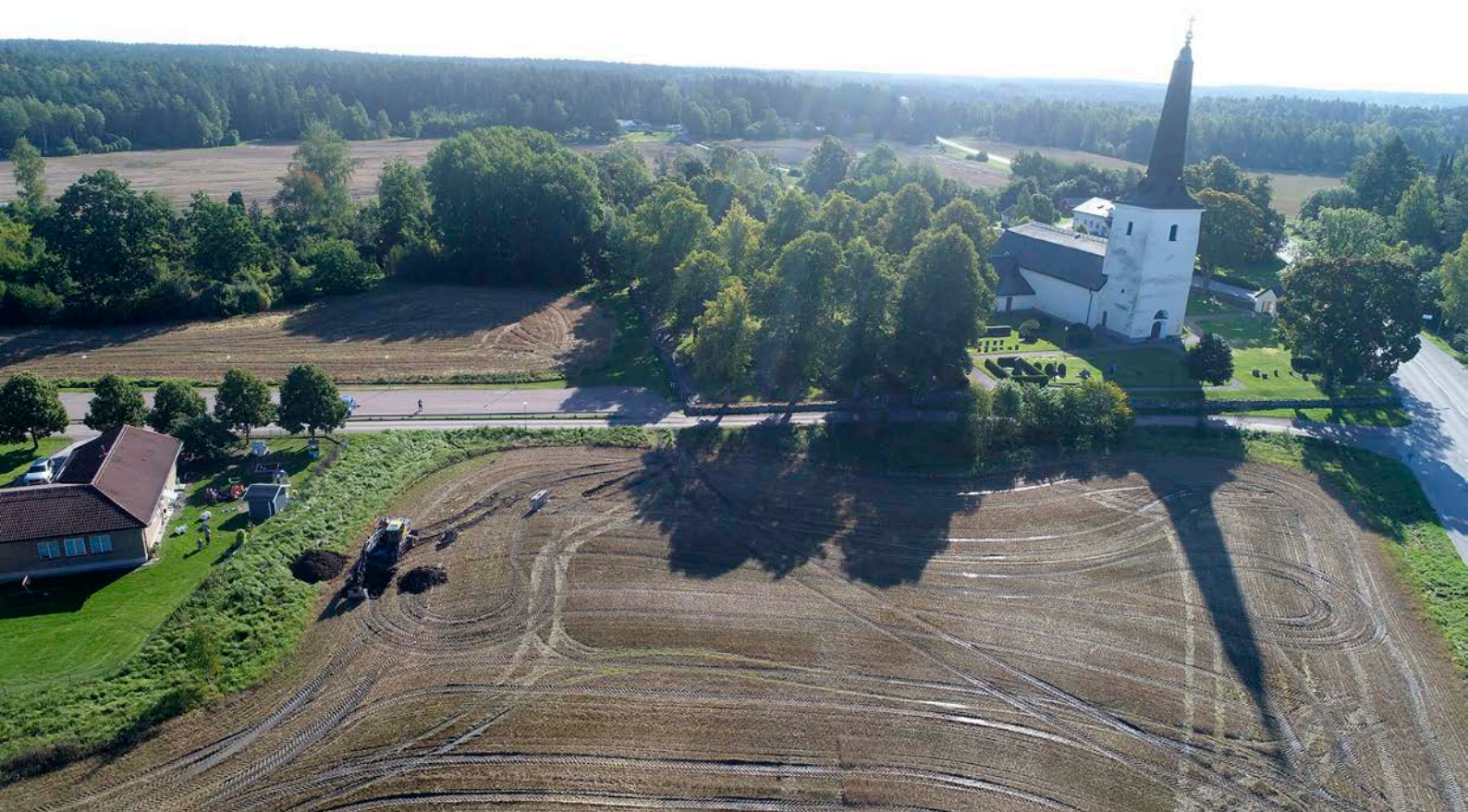
Figur 3. Vy över arbetsområde med Irsta kyrka och uppgrävt schakt till vänster i bild. Foto från öster.
