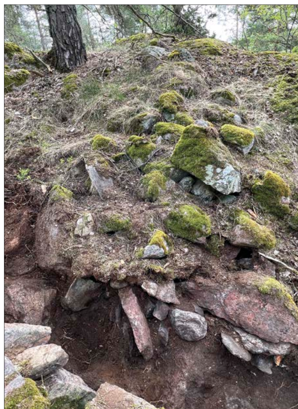
Figur 18. Sektion genom vall 104. Den översta bilden är tagen från sydväst och den undre från väster.
