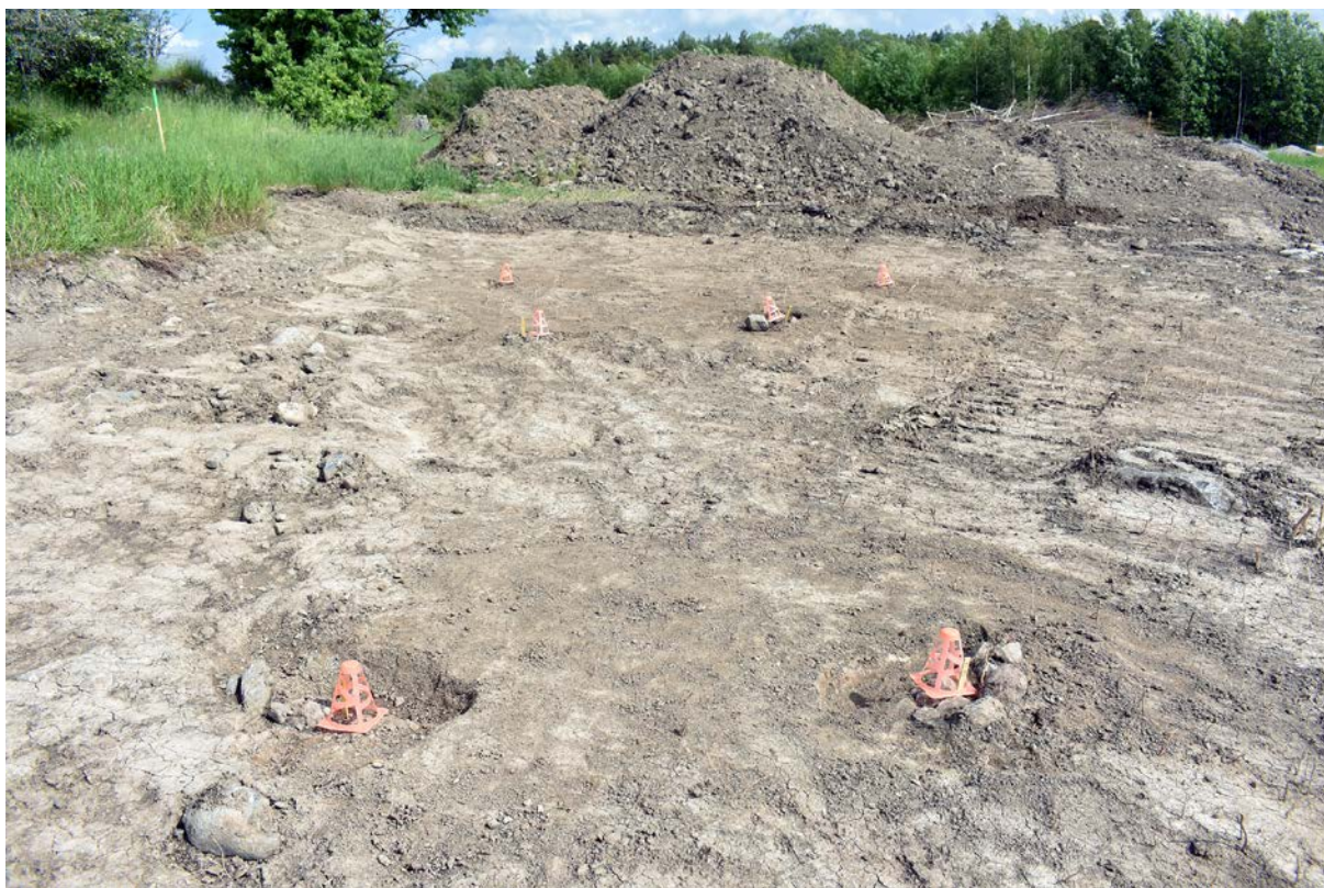
Figur 19. Hus 4 med stolphålen markerade med koner. Foto från söder.
