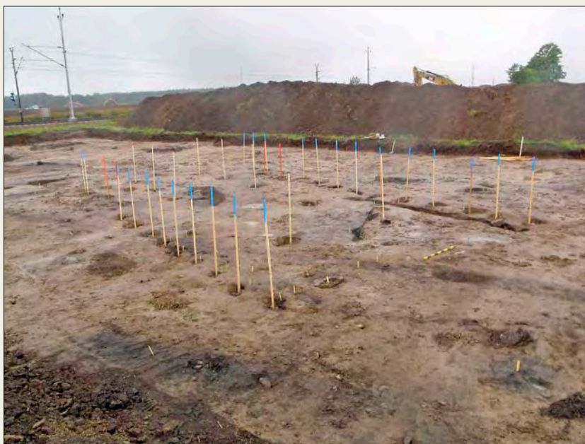
Figur 19. Hus 1 från sydost. Foto: Arkeologikonsult.
