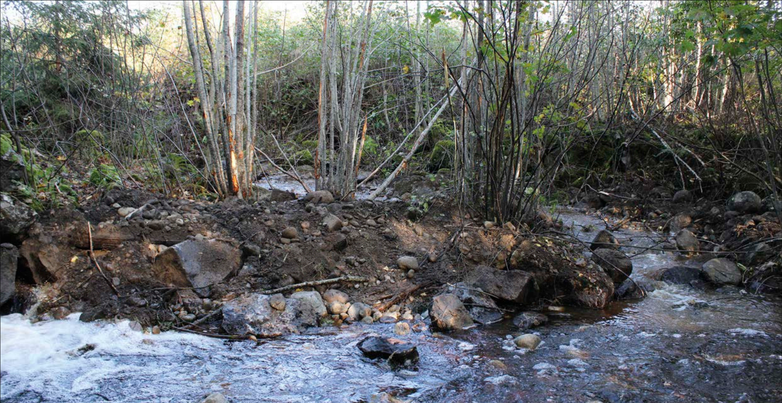
Figur 13. Mellan sidofåran och huvudfåran byggdes en vall för att styra vattnet. Foto från öster.
