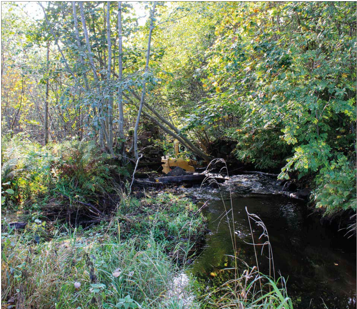
Figur 11. Maskinen skymtar i öppningen i dammvallen. Foto från norr.
