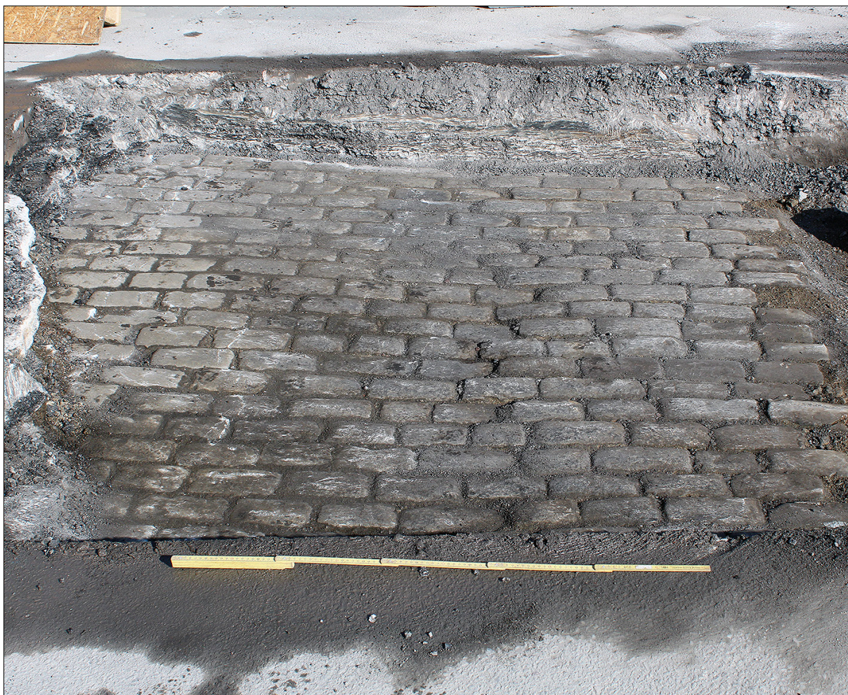
Figur 14. Sentida gatstensbeläggning (6602) av tuktad gatsten som framkom direkt under asfalten i norra delen av schaktningsövervakningarna på södra Skeppsbron. Foto från sydsydväst.
