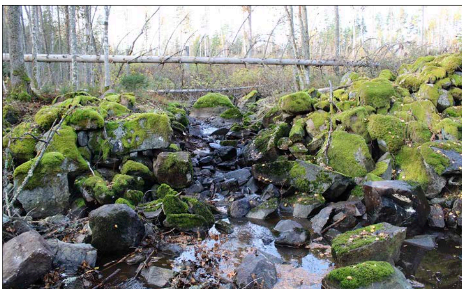
Figur 20. När schaktningen var avslutad hade dammvallens fåra bräddats till 1 meter. Foto från öster.
