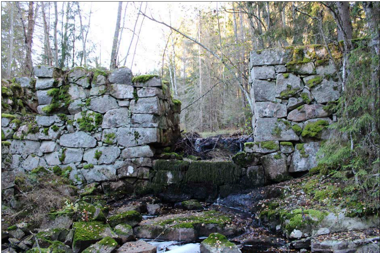
Figur 11. Dammvallens utskov (101) innan schaktning påbörjats. Foto från öster.
