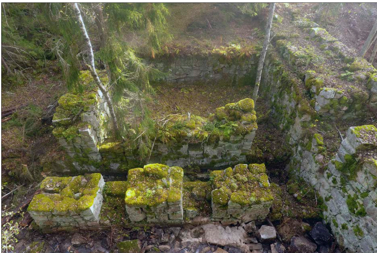
Figur 15. Kvarnruin vid schakt 1. I nederkant av bilden rinner Gärnsjöbäcken. Centralt i bilden syns kvarnens hjulgrav. Foto från norr.
