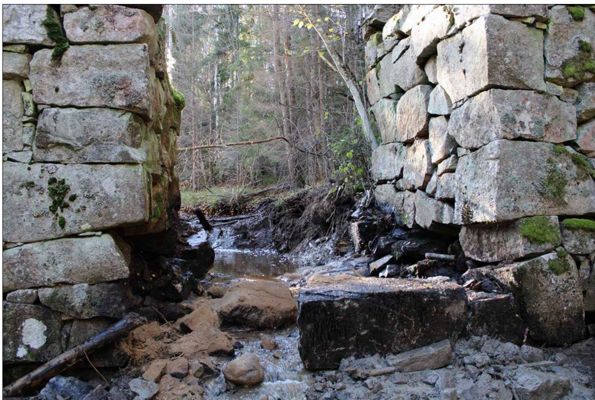
Figur 16. Dammvallens utskov efter schaktning. Utskovet (101) revs ur för att möjliggöra fiskpassager. Foto från öster.
