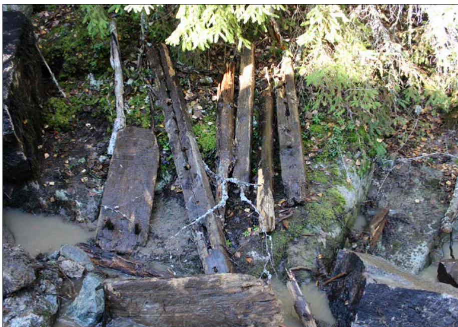
Figur 14. Delar av träkonstruktionen 104. Foto från söder.
