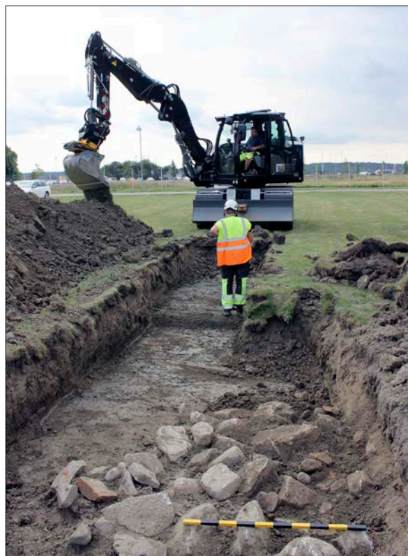
Figur 18. Konstruktion 201, sannolikt en del av en husgrund, i förgrunden. I bakgrunden schaktas det vidare i schakt 35. Foto från norr.
