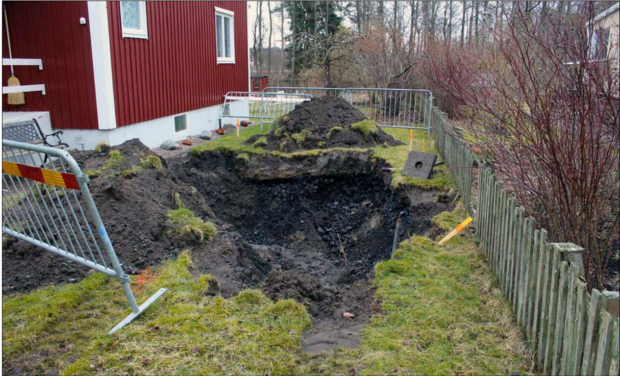
Figur 10. Schaktets södra del närmast huset. Foto från norr.
