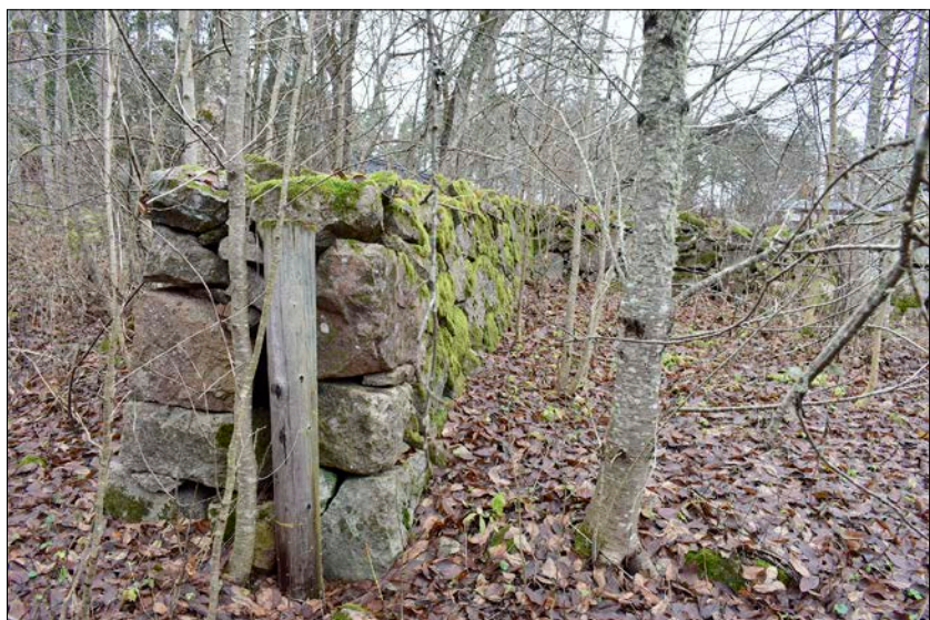
Figur 10. Den nordvästra delen av den stenmur som omgärdar den gamla trädgården. I förgrunden syns grindöppningen som leder till den tidigare odlade ytan utanför muren. Foto från sydsydost.
