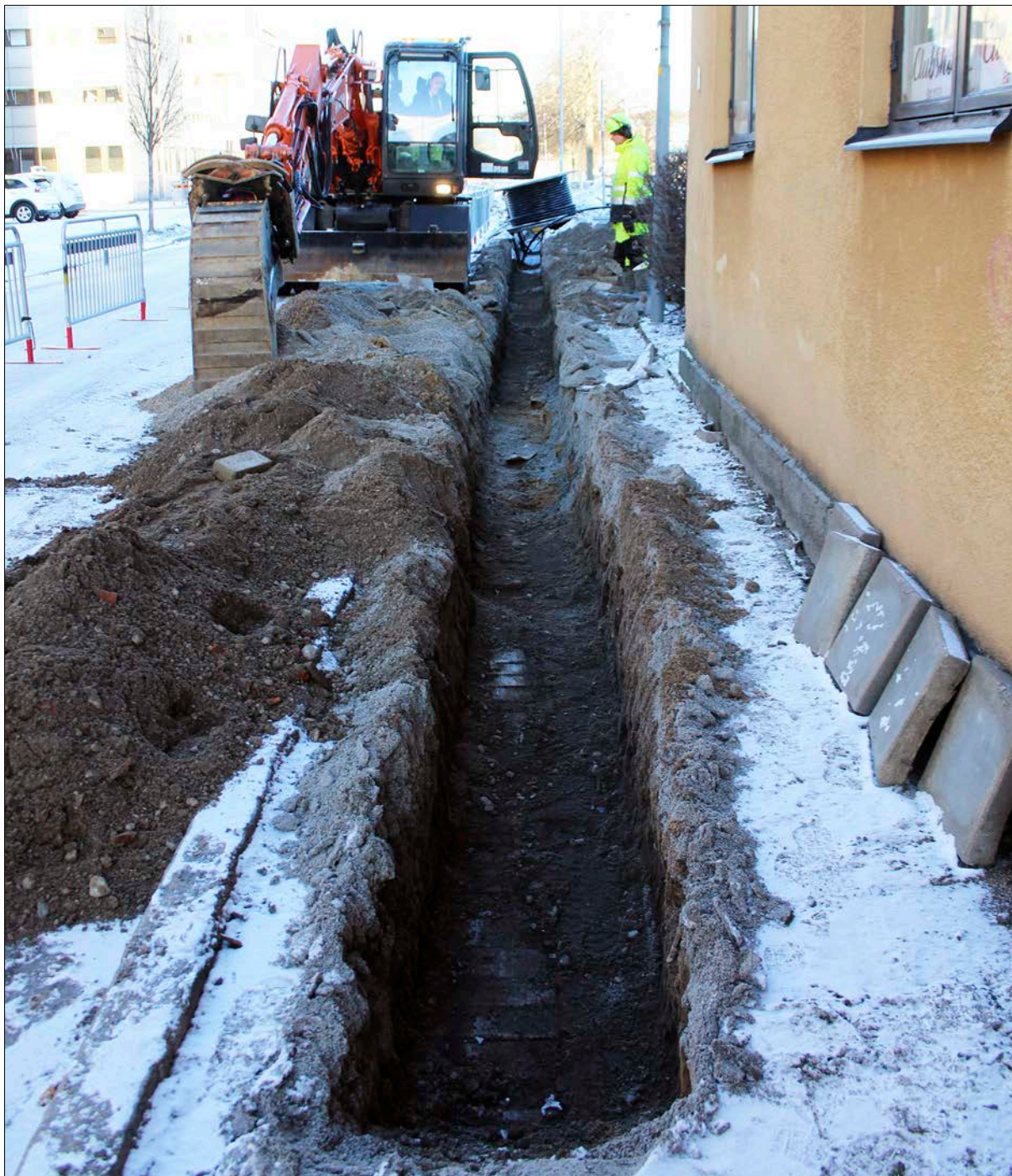
Figur 3. Schakt 2 upptogs i Orangerigatan intill den yta som undersöktes av Arkeologikonsult 2012 och 2016. I botten av schaktet syns plattor som låg ovanpå befintlig elledning. Foto från söder.
