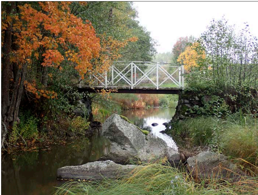
Figur 13. Bron nedströms dammvallen. Foto från söder.
