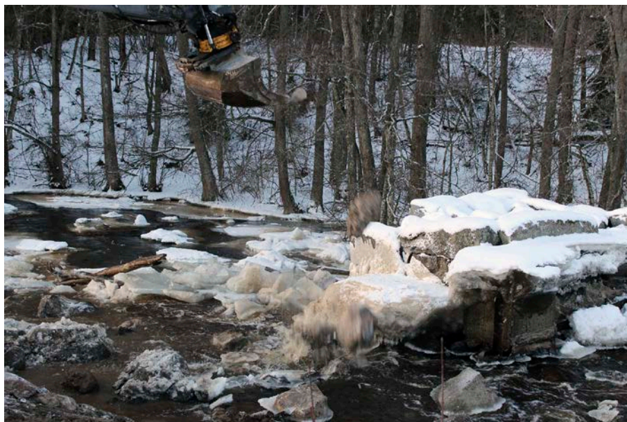
Figur 14. Stenar från den rivna dammvallen placerades ut i åfåran.
