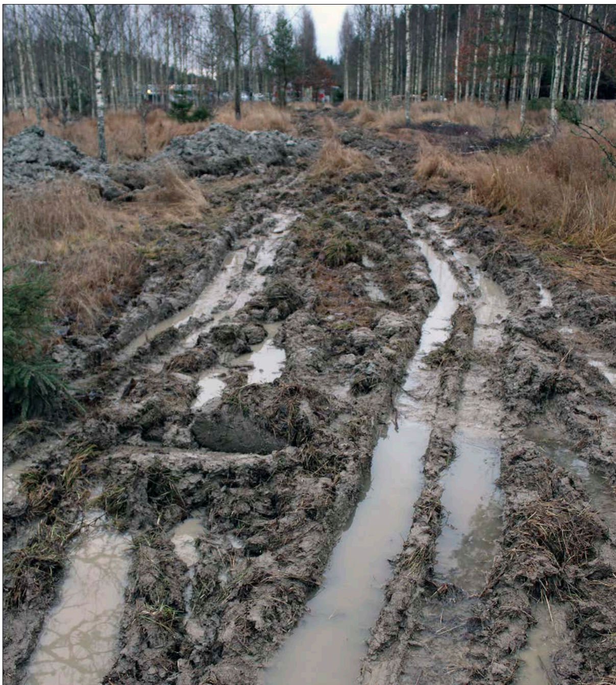
Figur 5. I den östra delen ansamlades mot slutet stora mängder vatten vilket begränsade grävmaskinens framkomlighet. Foto från norr.
