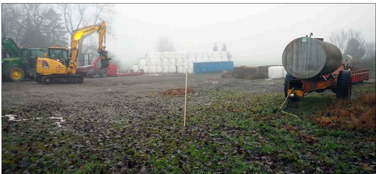
Figur 6. Upplagsplatsen som upptog ungefär hälften av förundersökningsområdet. Foto från nordöst.
