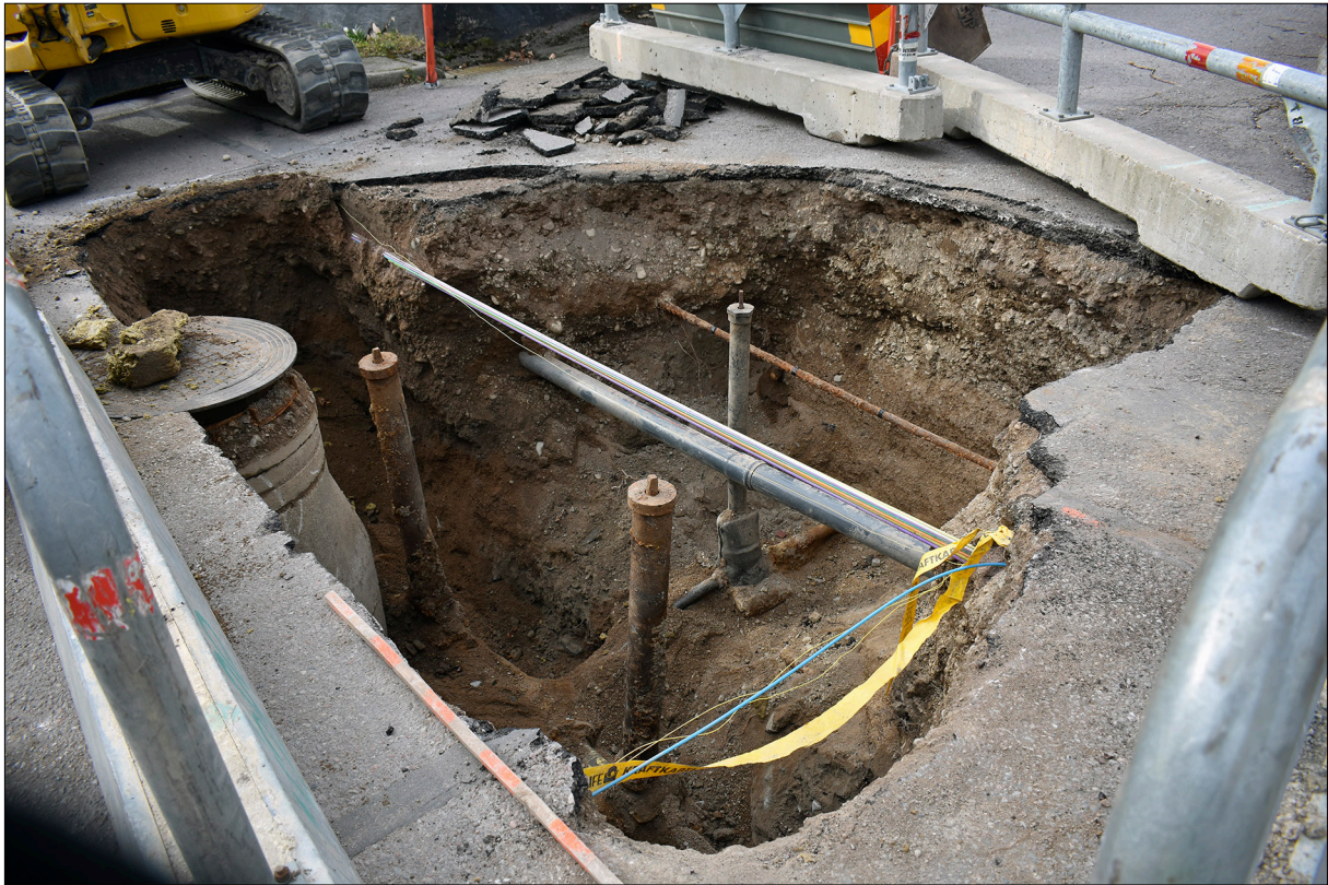
Figur 3. Samtliga upptagna schakt uppvisade spår från att ha grävts upp tidigare. I alla schakt fanns ledningar, serviser och rör. Schakt 2 fotograferat från väster.
