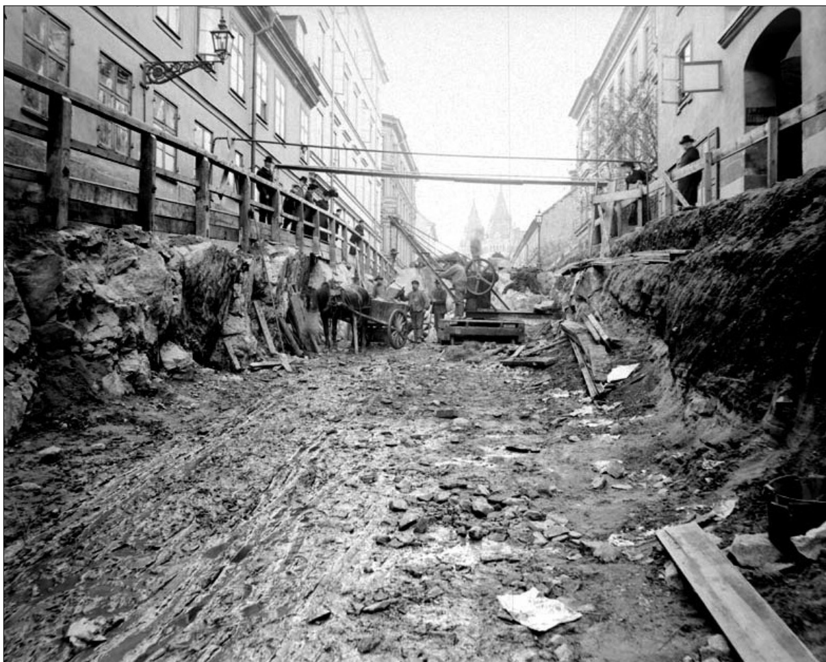
Figur 18. Sänkning av gatunivå för Riddargatan västerut mellan Nybrogatan och Grev Turegatan. I fonden kvarteret Sperlingens Backe. Fotografi taget av Oskar Lindahl, år 1909. Stockholms stadsmuseum, fotonummer C 3674.
