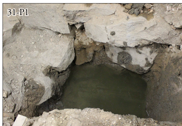
Figur 5. Fotografi taget från nordväst av provgrop 31-P1 med den stenmur som framkom. På bilden kan man se två skikt av sten i muren och ett tredje skikt som yttar sig under vattnet. Under detta skikt sten framkom en rustbädd för muren.
