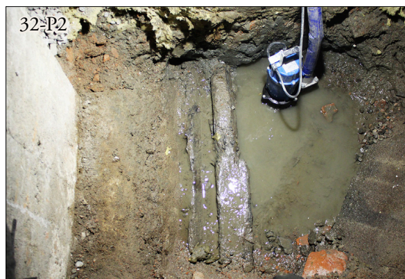
Figur 13. Fotografi taget från nordväst av botten i provgrop 32-P2. Träplank ovan betongfundament samt recent störning av isolering längs med provgropens sydöstra schaktvägg.
