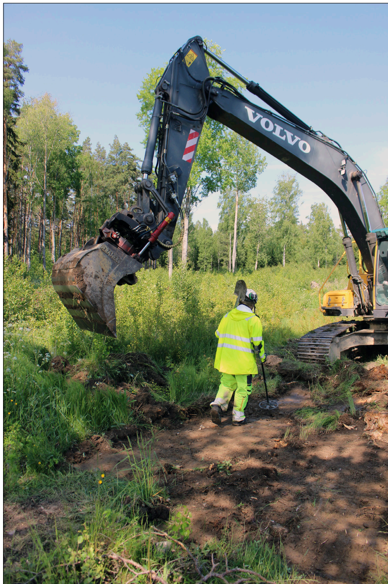
Figur 6. Jorden i samtliga sökschakt metalldetekterades skiktvis ned till undergrund. Foto från väster.
