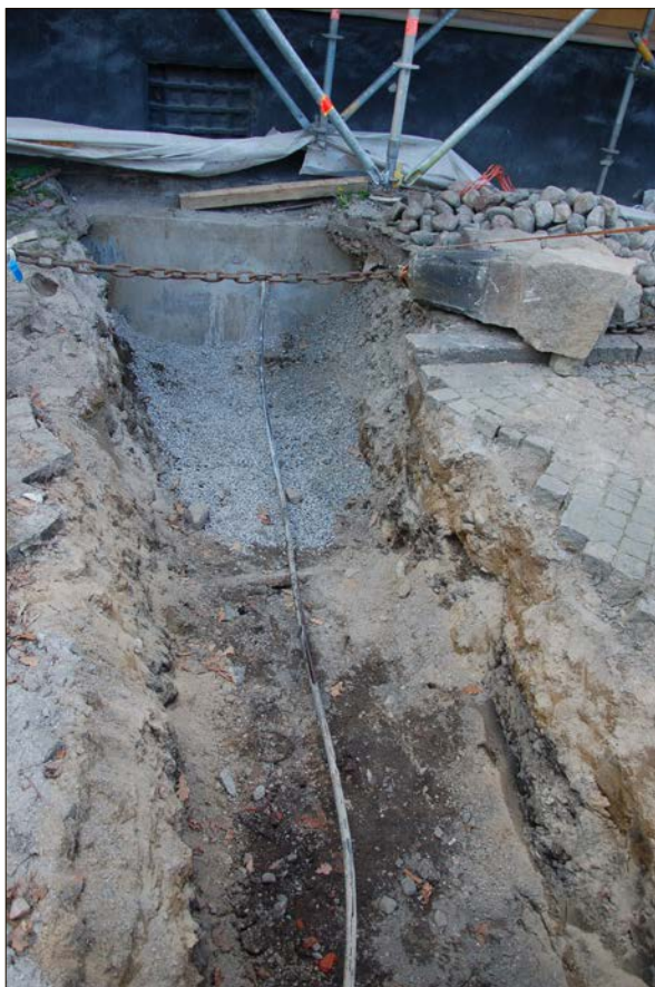
Figur 7. Foto över schaktets södra del som an knyter ledning till befintlig byggnad, med kulturlagerrest i schaktets botten (Lager 9). Från öster.
