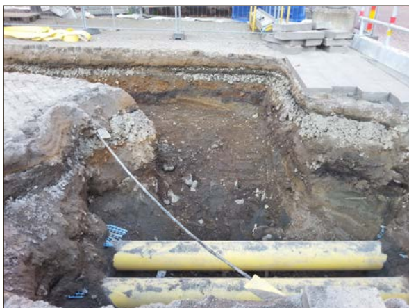
Figur 9. Foto över schaktets norra del med ledningar för fjärrkyla i förgrunden. I fotots högra del syns den mer leriga undergrunden och rester av ett kulturlager i sektionen. Från öster.
