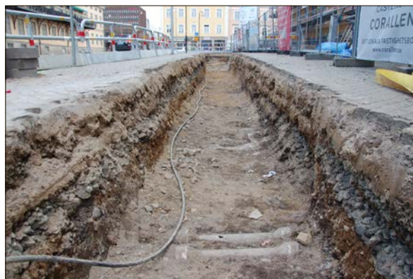
Figur 8. Foto över schaktet i sin helhet från norr, illustrerande de moderna utfyllnadslagrens måktighet samt rörledningar och betongkista i dess norra del.
