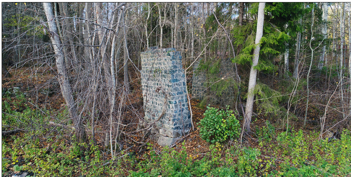
Figur 15. Fundamenten (117) för anslutningen till logens (108) övervåning var uppbyggda av slaggtegel. Foto från nordöst.
