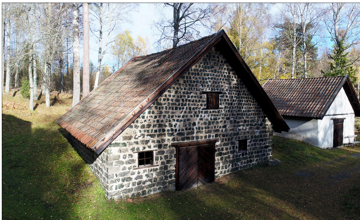
Figur 37. Möjligen kan hus 110 vara ett magasin likt det rekonstruerade tackjärnsmagasinet vid Trehörnings hytta som uppförts i slaggtegel. Foto från sydväst.
