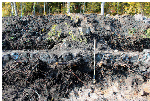
Figur 11. Grundmurarna i hus 110 var uppbyggda med slaggtegel och lagda i terrasseringsmassor 104. Foto från öster.
