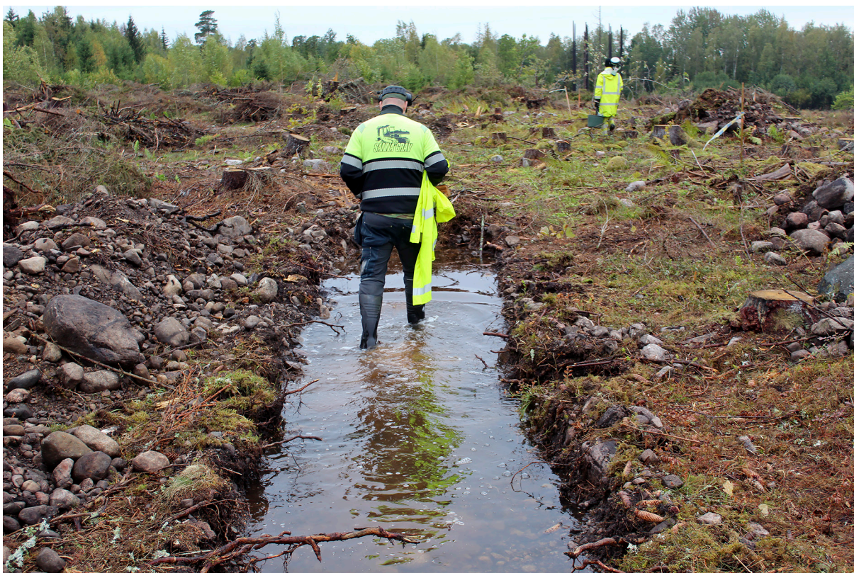
Figur 27. Schakten vattenfylldes vid regn trots markens beskaffenhet. Foto från söder.
