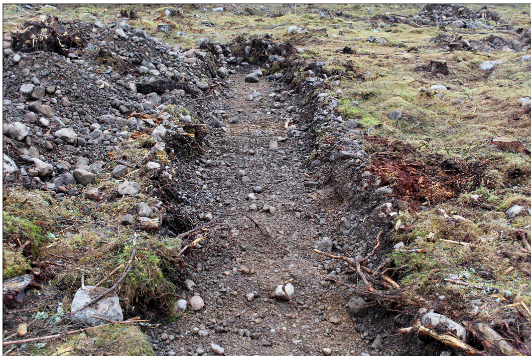
Figur 21. Schakt i moränen i anslutning till L1979:3013. Foto från öster.
