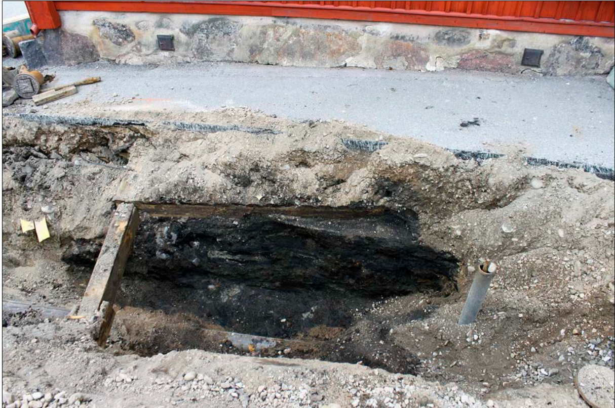
Figur 19. Översikt över lager 106 i schakt 8. Till vänster i bild samt ovanför lagret syns en elledning som var inbäddad i ett trähölje (störning 212). I nederkant syns den befintliga vattenledningen som avgränsade lagret åt öst. Foto från öster.
