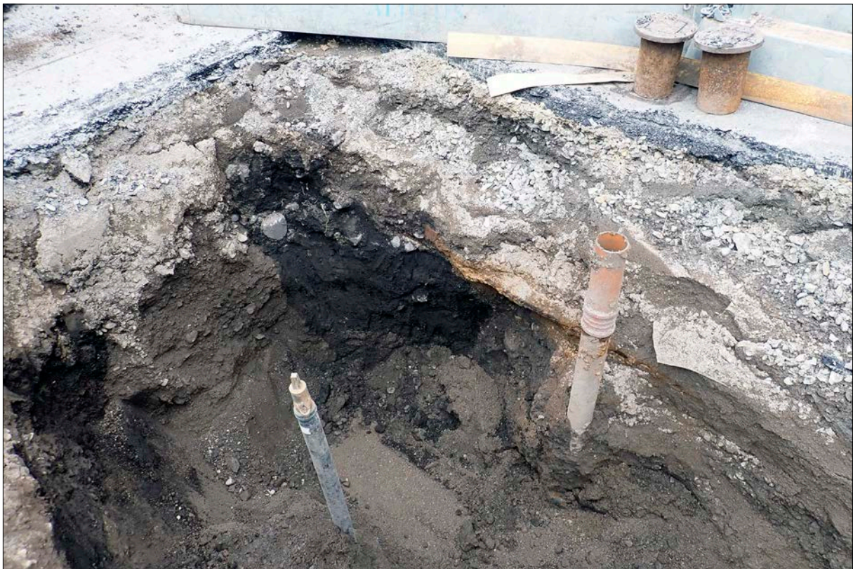
Figur 8. Lager 100 i schakt 5. Lagret var tydligt skuret i respektive ände av moderna nedgrävningar. Foto från sydöst.
