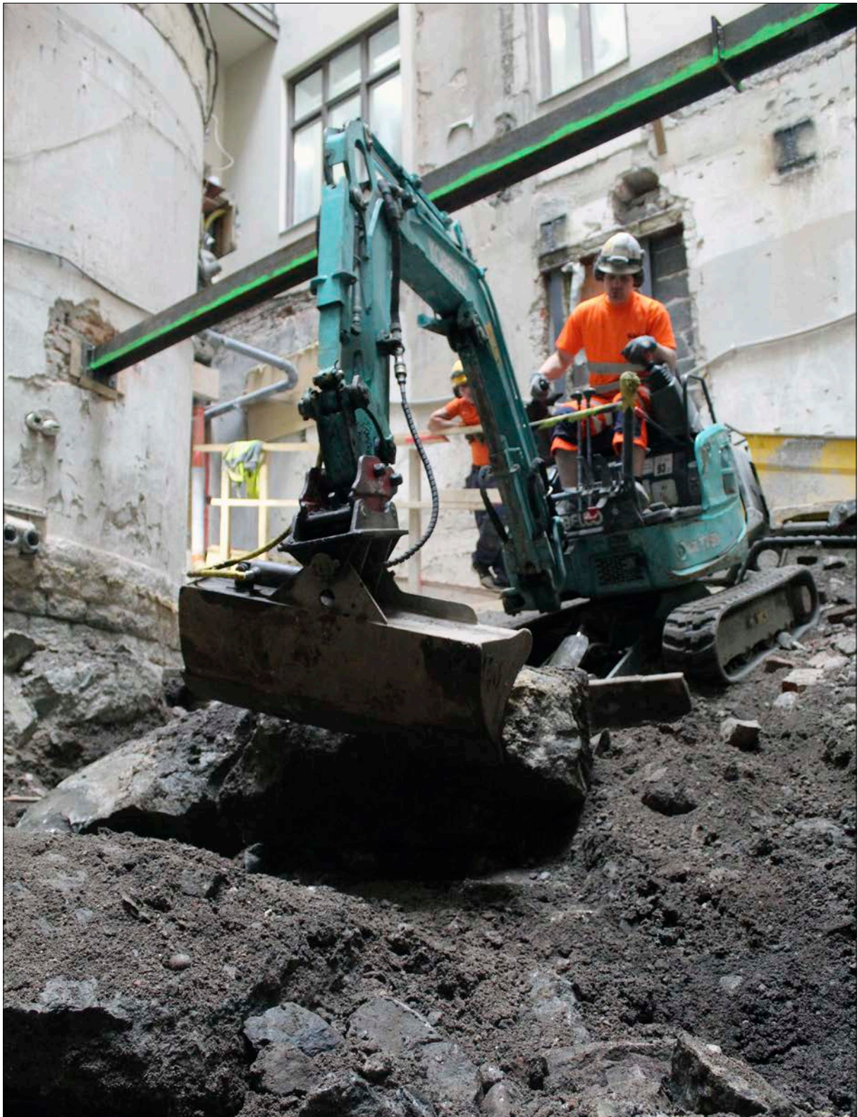
Figur 11. Schaktningsarbete på innergården. Många av de stenar som använts i den sentida utfyllnaden av innergården var rejäla och fick sönderdelas innan de kunde fraktas bort. Foto från sydost.
