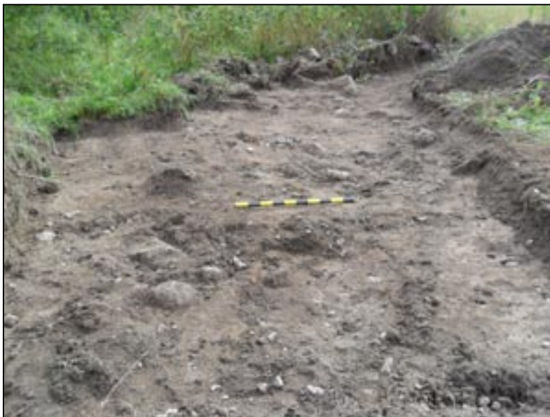
Figur 6. Foto av schakt 13. Längst bort i schaktet ser man syllstensraden 103. Fotograferat från nordväst.
