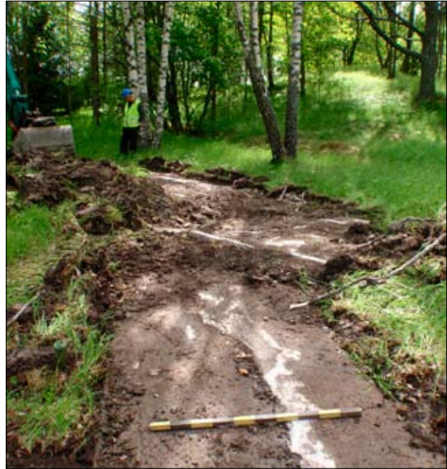
Figur 3. Betongplattan (A 1000) under framschaktning. Foto från nordväst.
